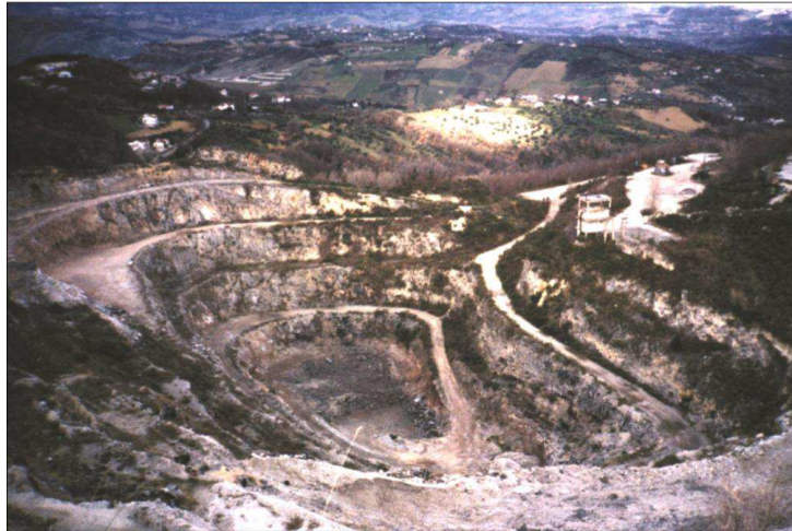
Fig. 1: ripresa fotografica del cantiere "Foce Valle Romana"
