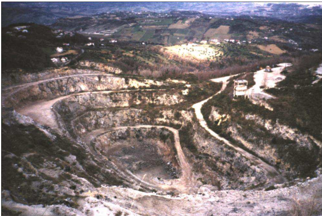
Fig. 1: ripresa fotografica del cantiere "Foce Valle Romana"
