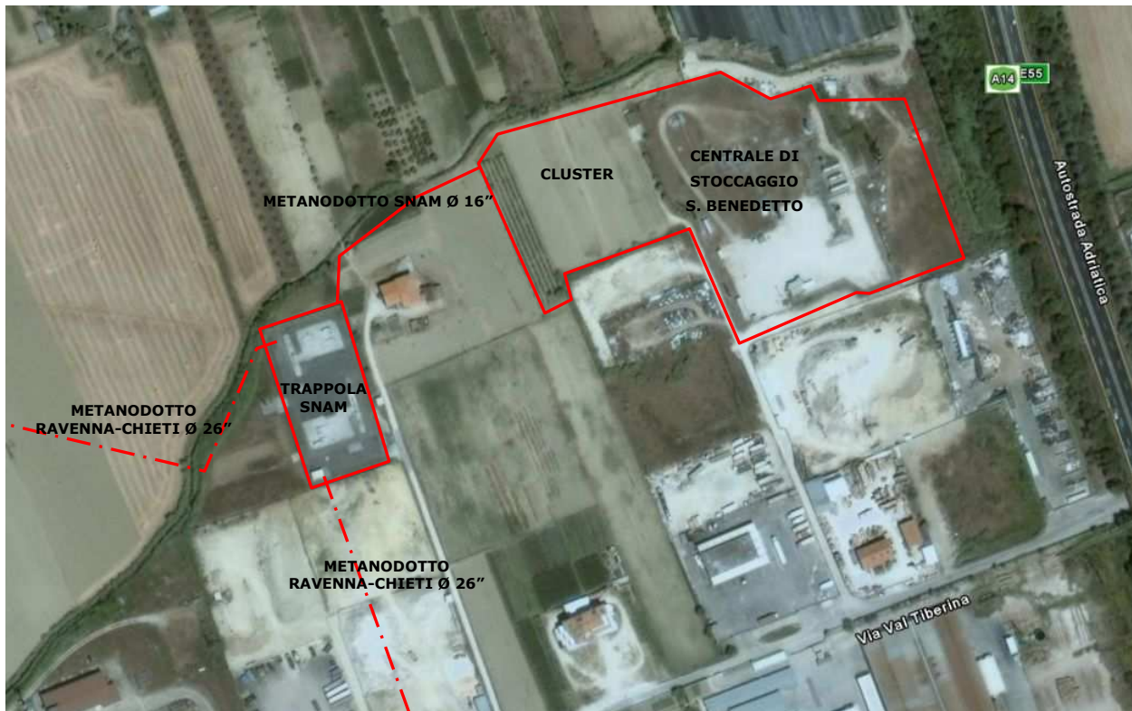
Figura 3-2 – Localizzazione degli impianti
